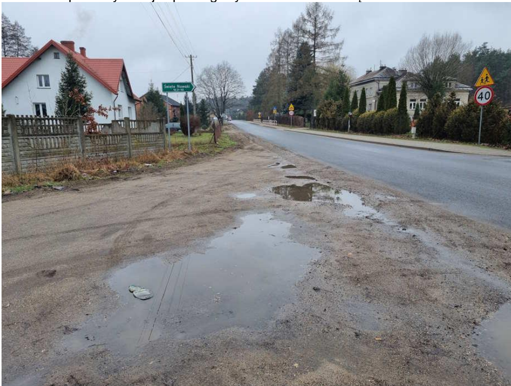
Fotografia 11. Stan poboczy i miejsc parkingowych w sołectwie Święte
